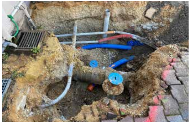
Le chantier du cœur de village est rendu particulièrement complexe par les nombreux réseaux à renouveler qui s'entremêlent. Ici au pied du Maryland.
