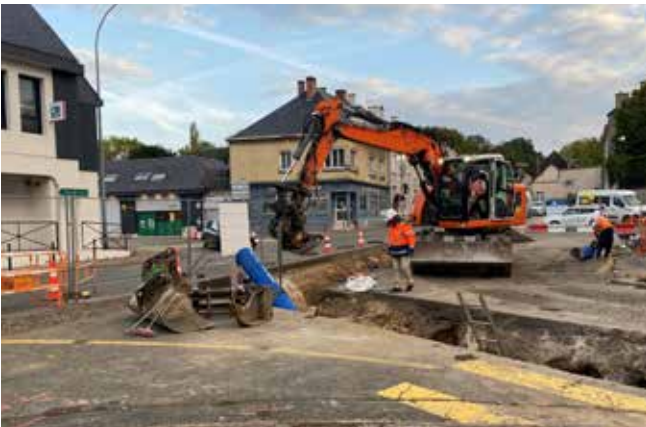
Fin 2023, une bonne partie du chantier a été consacrée à la reprise complète des réseaux secs et humides en plein cœur du carrefour, nécessitant des fermetures à la circulation.
