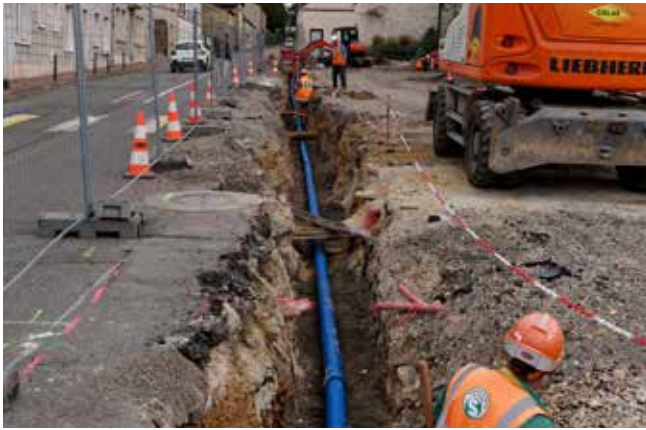
Les travaux de la phase 2 ont démarré en octobre 2023 par le renouvellement des réseaux humides au niveau de l'ancien parking de la Poste.
