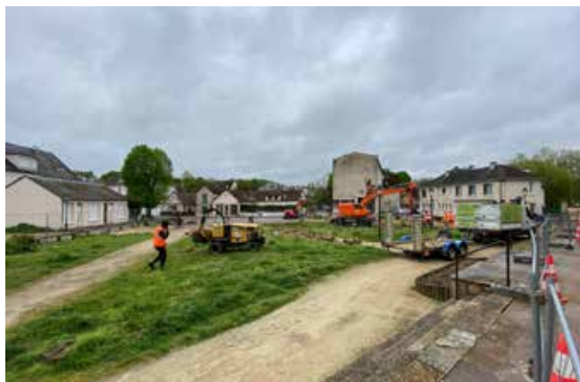
Démarrage de l'installation du chantier place de l'Eglise début mai.
