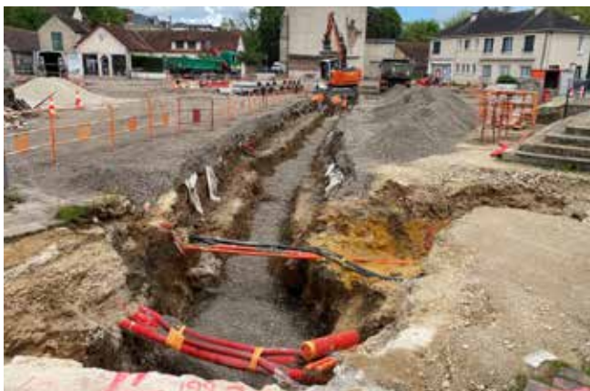
Réalisation de la tranchée pour le nouveau réseau d'évacuation des eaux pluviales traversant toute la place de l'Eglise.
