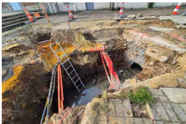
Début des travaux de réseaux fin mai. Ici tranchée pour poser le nouveau réseau d'évacuation des eaux pluviales vers le Couasnon.
