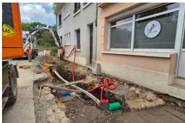
Prolongement de la pose du nouveau réseau d'adduction d'eau potable rue des Grands-Prés en juin, avec difficulté de passer sous les nombreux réseaux secs présents.
